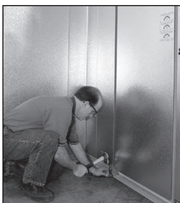
Instale el anclaje
