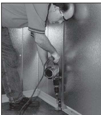
El tamaño de agujero recomendado para el sistema PARABOLT ANCHOR es 3/8" X 2-1/4"
