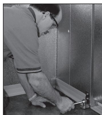
Sujete la riostra de sostén con el sujetador provisto
